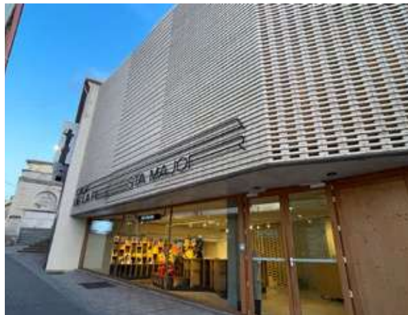
Imatge de la renovada façana de la Casa de la Festa Major
